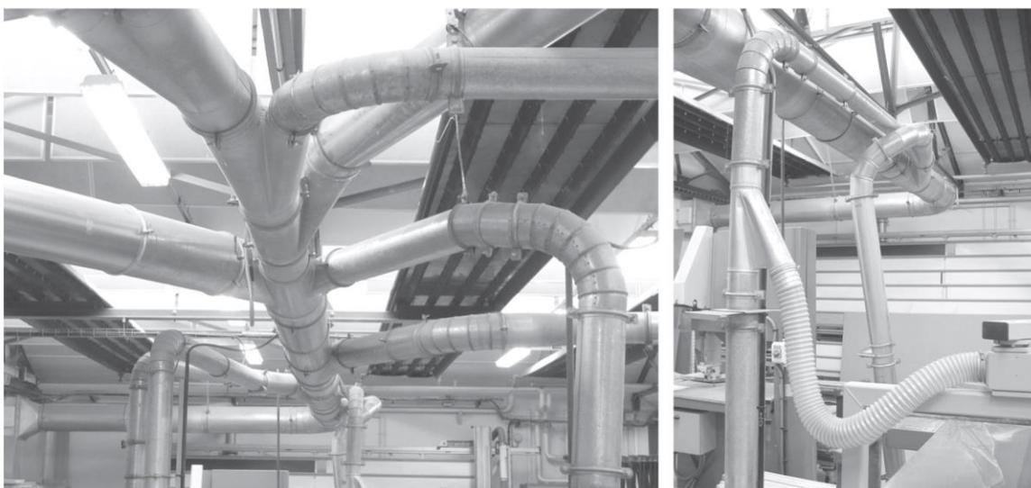
**Chaque raccordement de machine est équipé d'une trappe** pour ouvrir et fermer l'aspiration. Ces trappes sont à manipuler avant et après chaque utilisation de la machine. Si elles restent ouvertes inutilement, elles réduisent nettement la puissance d'aspiration des autres machines. Leurs manipulations peuvent être manuelles ou automatisées avec le démarrage de la machine.
