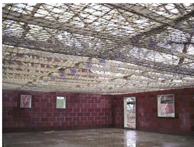
Fig 31 - Filets en sous-face de la charpente
