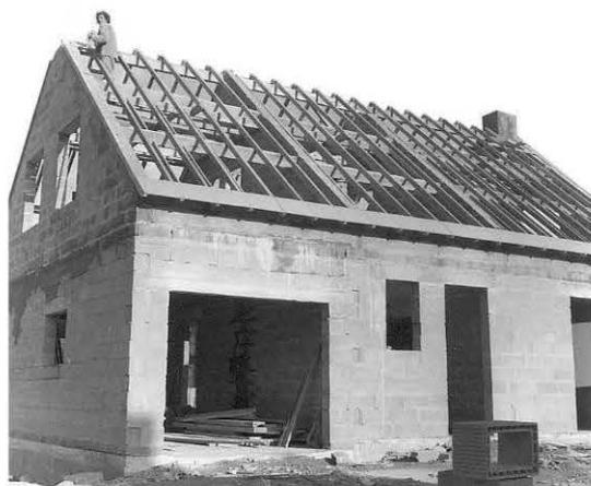
**Vue n° 3 :** pavillon à combles aménageables; charpente : pannes avec appuis sur pignons extérieurs et intermédiaires
