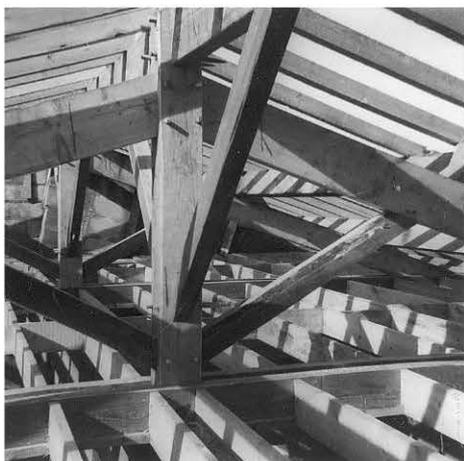
**Vue n° 5 :** détail d'une ferme porteuse de la charpente et du faux solivage pour le plafond
