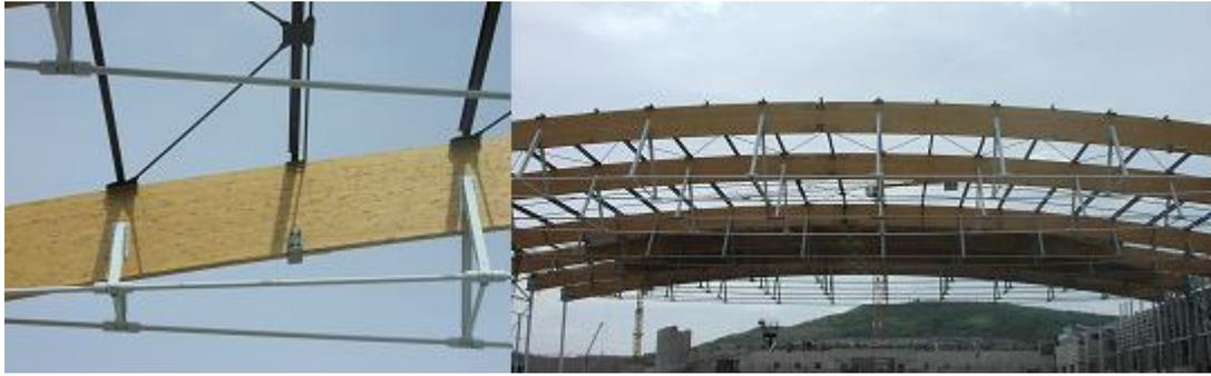
Figure 10-3 : La Grande Halle d'Auvergne : poutres courbes sous-tendues autostables
